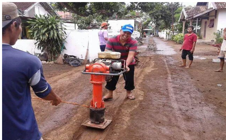
Gambar 3.17 Pemadatan galian pipa
