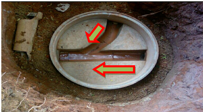
Gambar 3.10 Potongan Bak Kontrol ( Precast )
