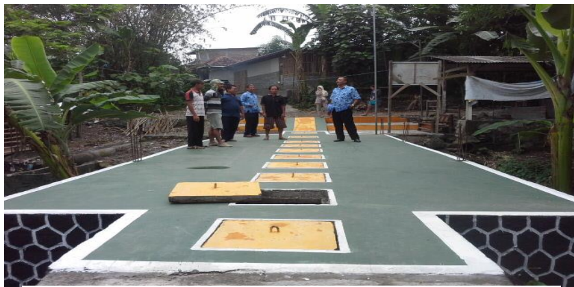
Gambar 3.5 IPAL Komunal DAK Infrastruktur Kabupaten Bantul Provinsi Yogyakarta 100 KK
