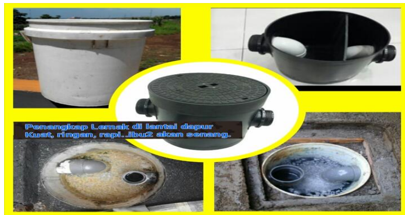
Gambar 3.12 Bak Penangkap Lemak (Pabrikasi tengah, Kabupaten Jombang bawah) Provinsi Jawa Timur
