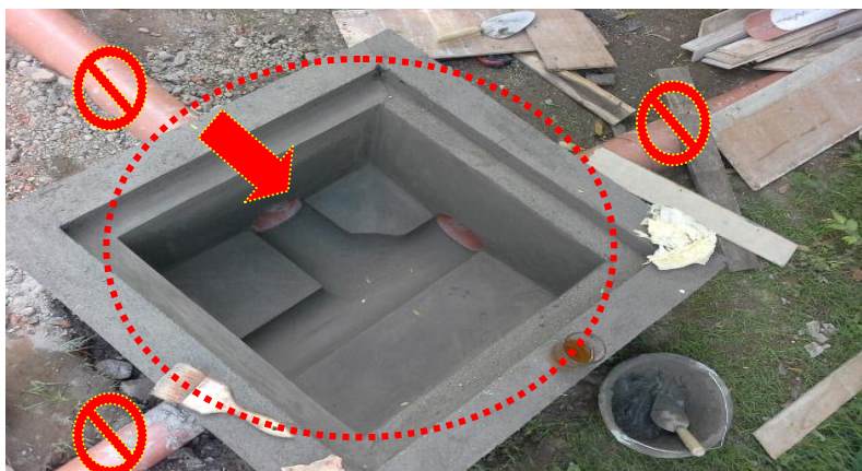
Gambar 3.11 Pengerjaan Bak Kontrol DAK Kabupaten Brebes Provinsi Jawa Tengah
