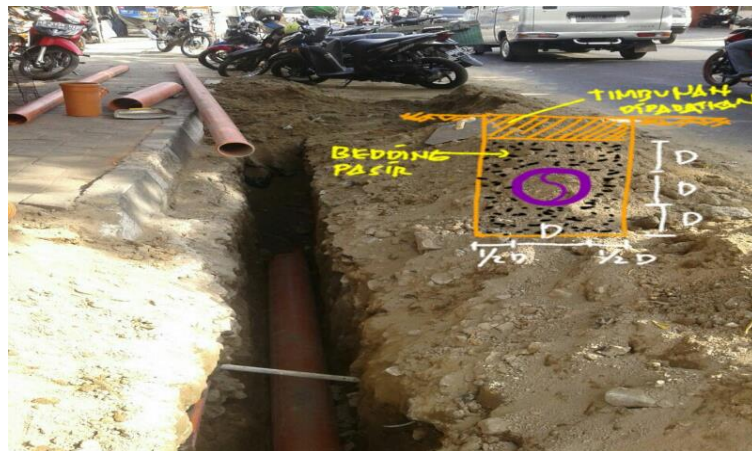
Gambar 3.16 Pemasangan Bedding Pasir pada jaringan
